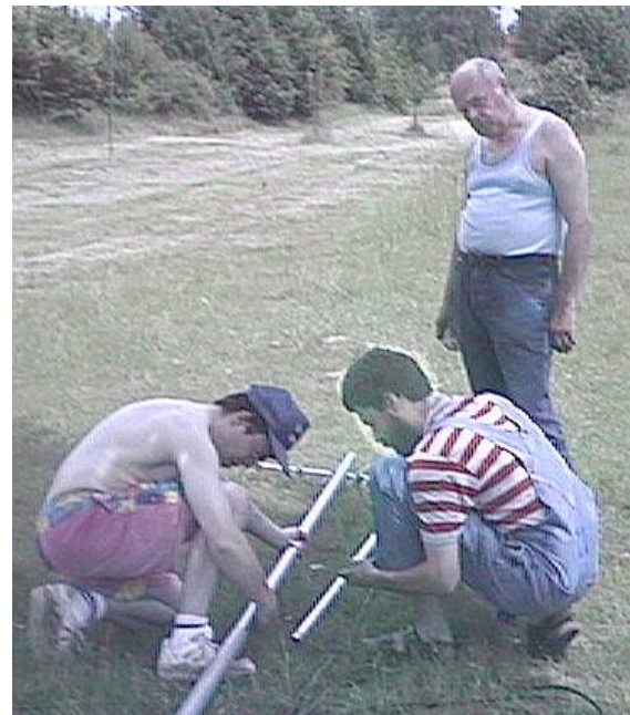
Die 70cm Richtantenne für Packet-Radio wird installiert.
