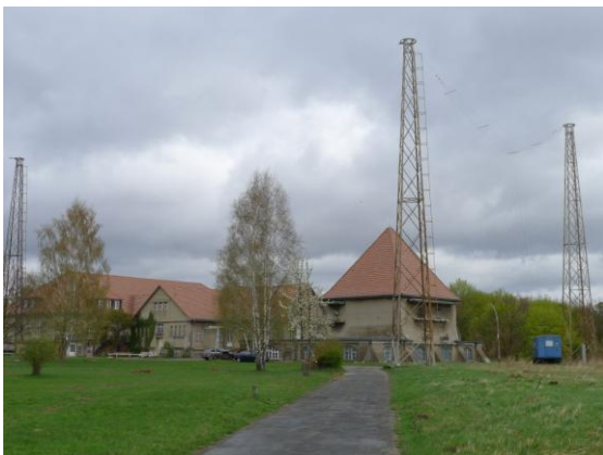
Bild: DF2PI / Weiträumige Sendeanlage mit Masten
