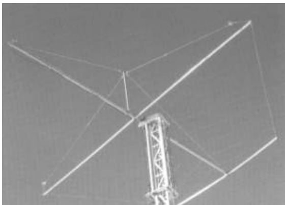
Rohmontage konnte beginnen.
